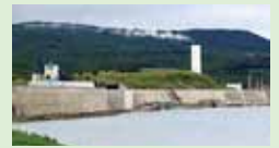
14キロにおよぶ防潮堤
