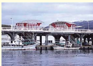
奥尻青苗漁港の人工地盤
