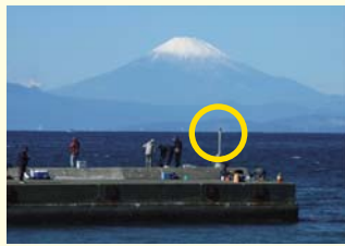
消失した防波堤先端部
