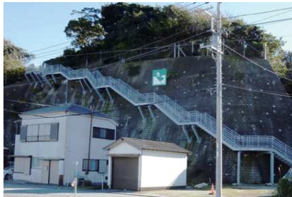
城ヶ島に設置されている避難階段
